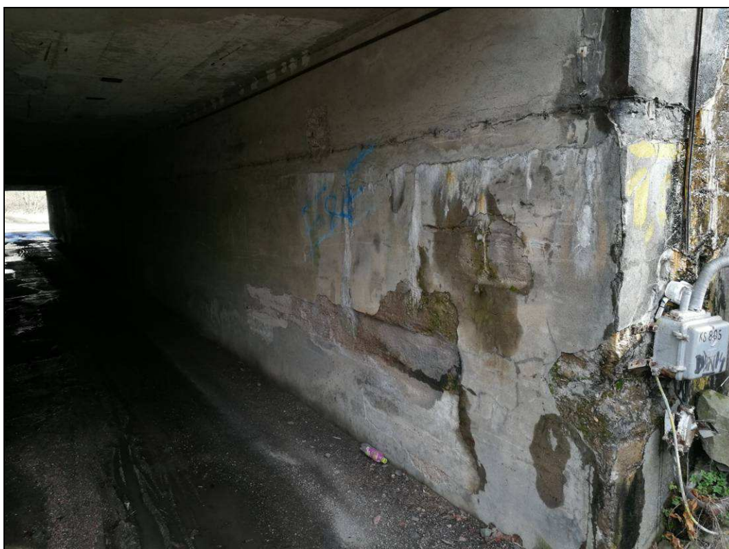
Obr. č. 7 - pohled na opěru Č. Třebová s trhlinami a průsaky
