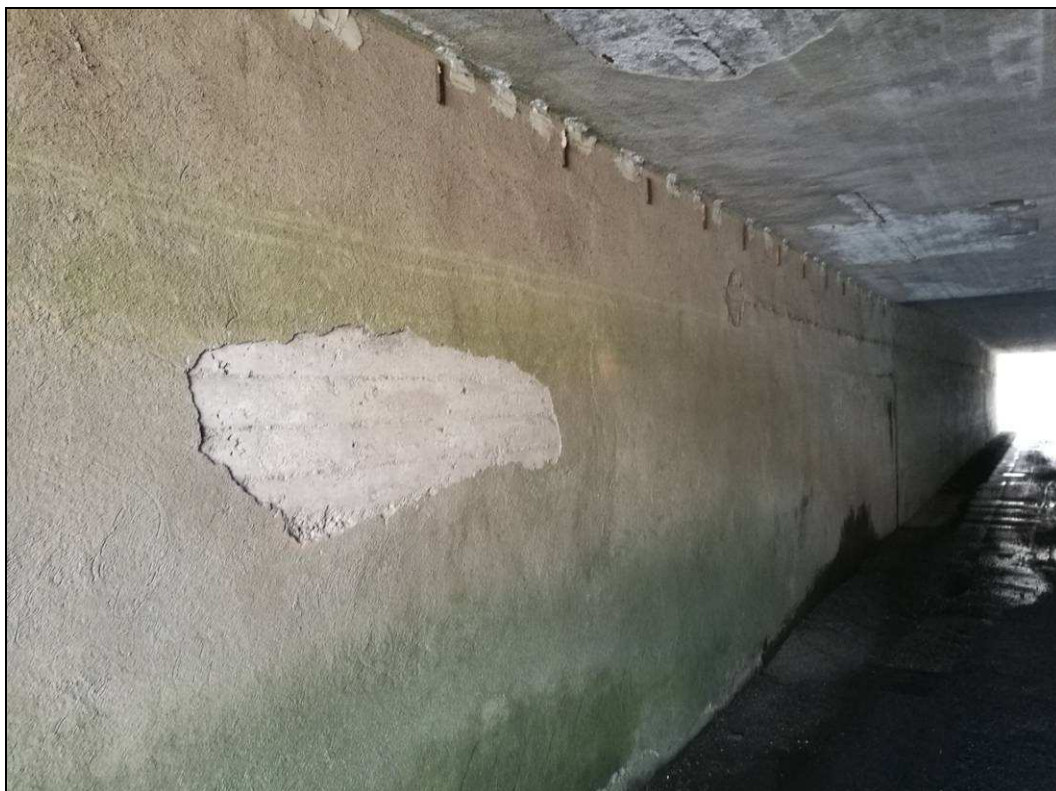
Obr. č. 6 - pohled na opěru Zábřeh n. M. s lokálními opady omítky
