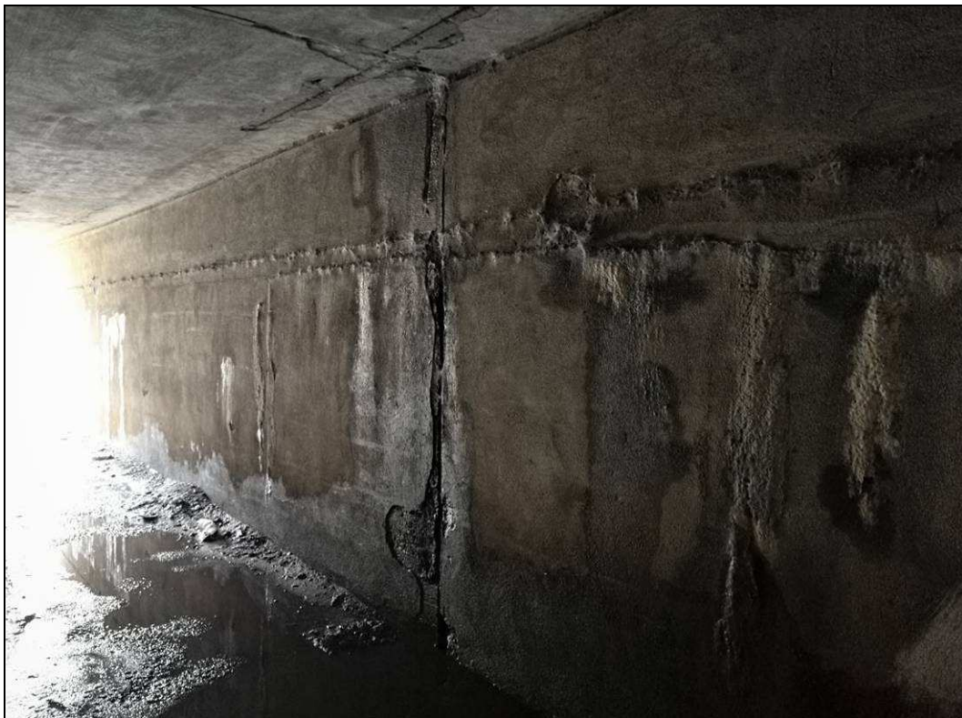
Obr. č. 8 - pohled na opěru Zábřeh n. M. - dilatační spára s opady omítky a průsaky - vodorovné vlasové trhliny s průsaky a vápennými usazeninami
