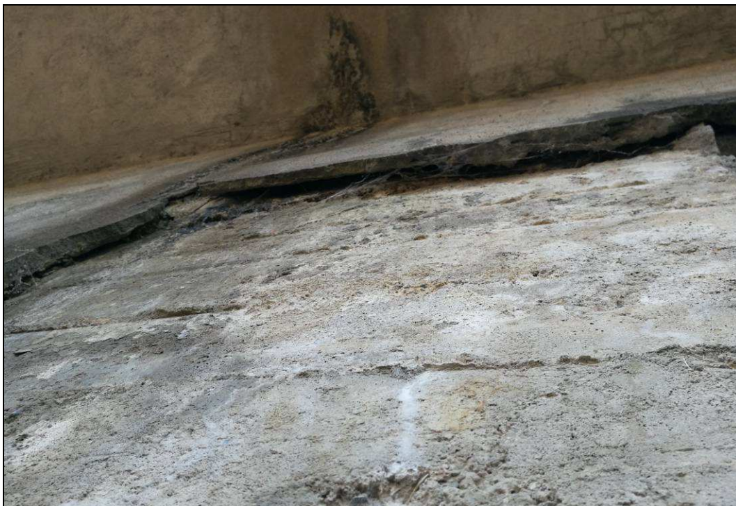
Obr. č. 9 - pohled na levé čelo - omítku oddělenou od podkladu
